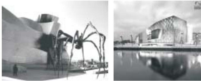
Fig 3, 4 - Bilbao: Guggenheim Museum Bilbao (Frank Gehry) and Euskalduna Auditorium
